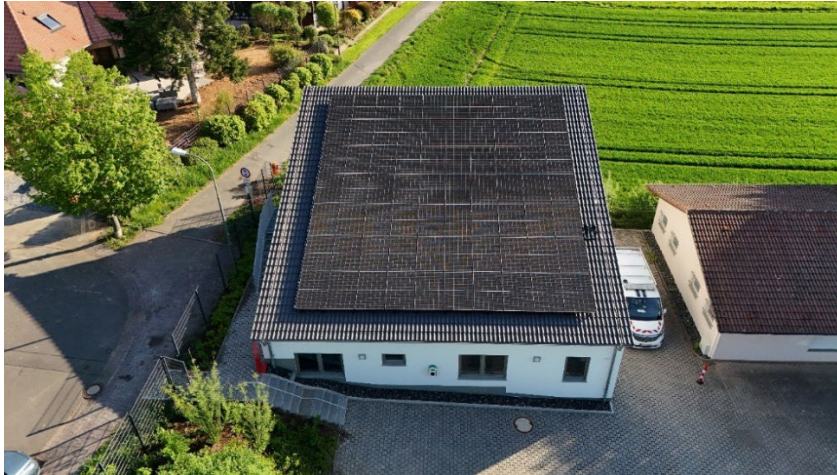
Abbildung 5 PV-Anlage Atemschutzwerkstatt Petersberg
