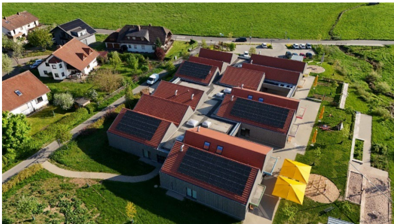
Abbildung 4 PV-Anlage Kita "Zipfelmütze" Petersberg
