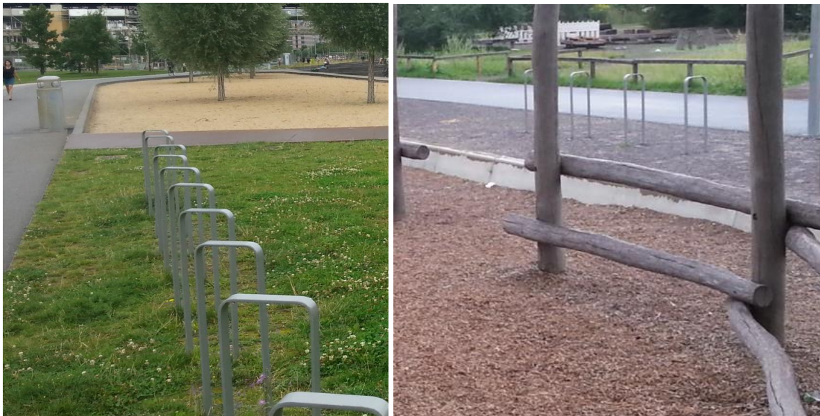
Anlehner auf Schotterrasenfläche, Park am Gleisdreieck Berlin. Direkt einem Spielbereich zugeordnete Metall-Fahrradbügel sowie im Hintergrund einfache Holzanlehner, die zugleich als Angrenzung dienen
