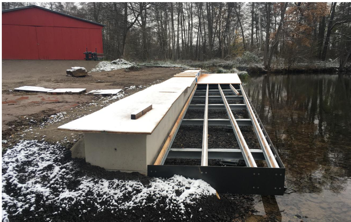
Fotobeispiel: Uferterrasse mit Holzbelag am Aueweiher für die LGS Fulda. Bauphase Dezember 2022
