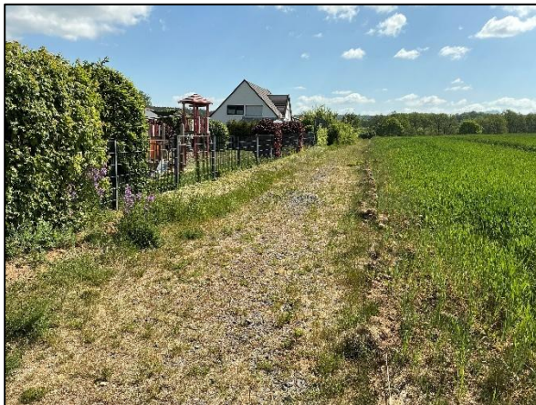
Abb. 19: Schotterweg mit Bewuchs sowie Entwässerungsmulde zwischen Zaun und Weg (Aufnahme 05/2025)
